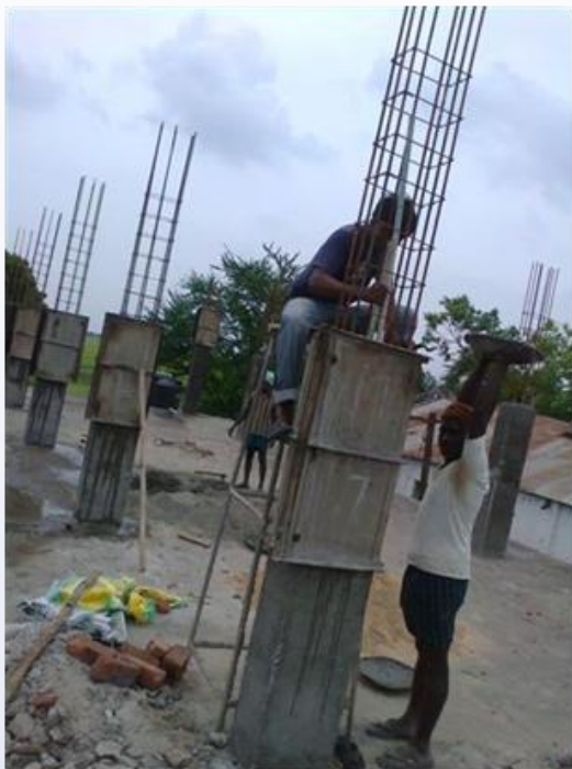
Die tragenden Stützen werden verlängert für das Obergeschoss
