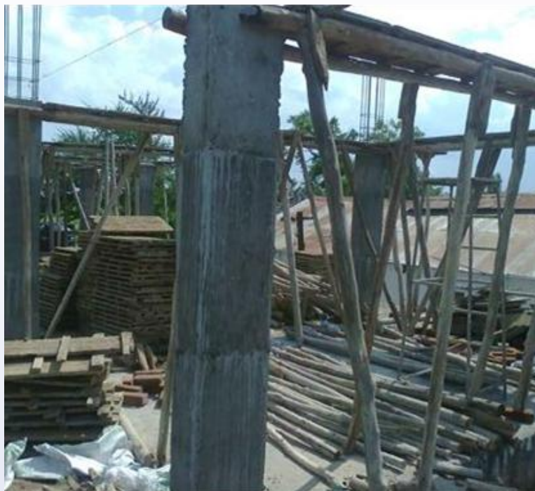
Die Deckeschalung wird mit einfachen Holzspriessen gestützt.
