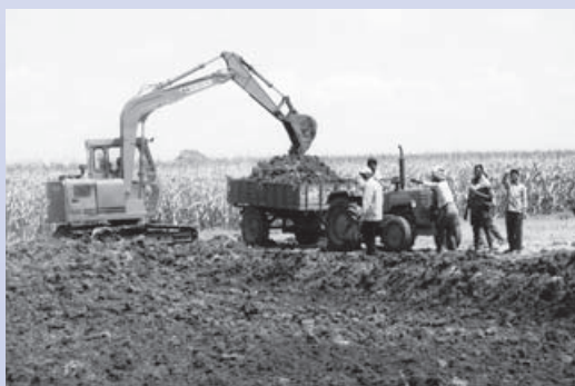
Planierungsarbeiten mit einfachen Geräten
