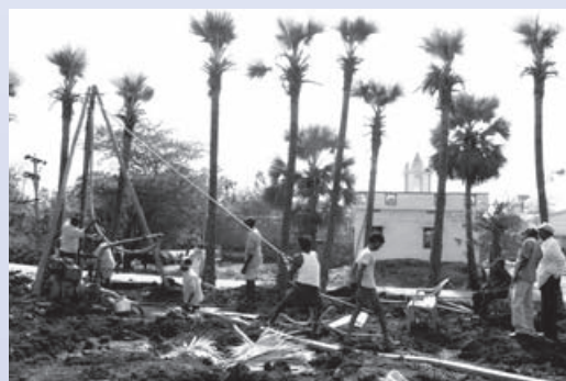
Bohrarbeiten für den eigenen Trinkwasserbrunnen.
